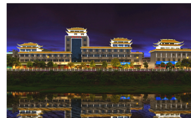
湖南道县中国税务局大楼亮化工程
